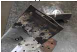
Pomiar składu chemicznego z wyciętych próbek
