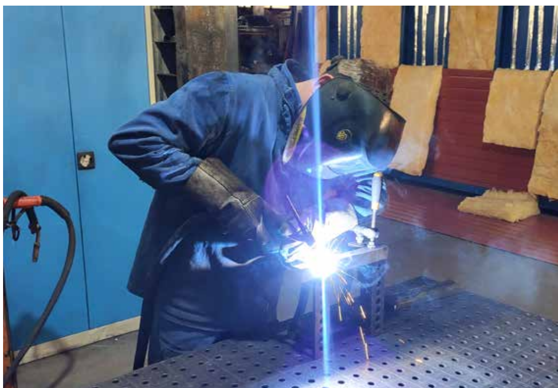
Możliwość wykonania przyrządu spawalniczego zapewniającego poprawność wymiarową już przy jednej sztuce
