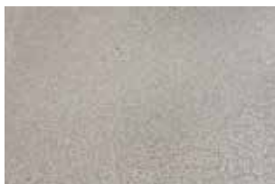
Obróbka strumieniowa ścierna Sa 2,5 do Sa 3,0
